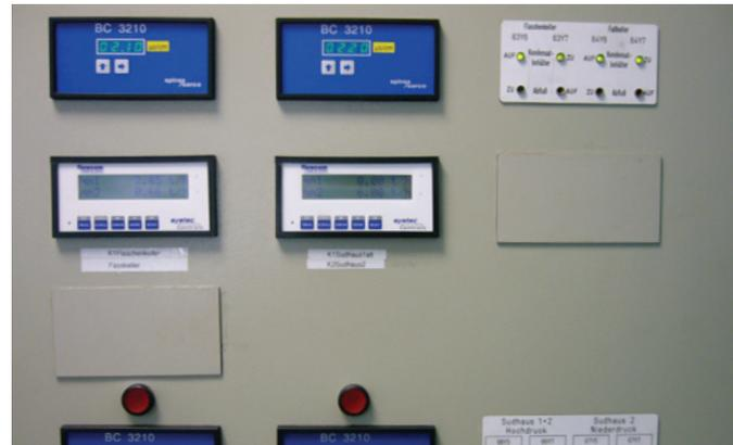
Die Vorteile mehrerer Leitfähigkeitsüberwachungssysteme sind, dass geringere Mengen verunreinigten Kondensates automatisch verworfen werden.
